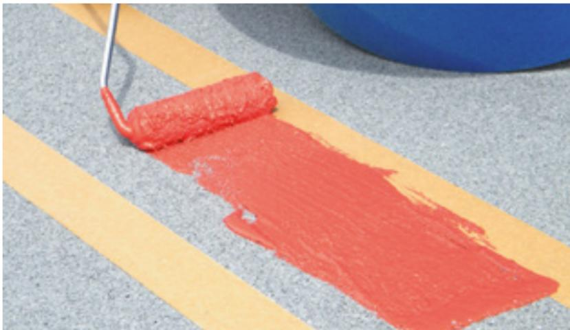
3. PROFI-DICHT-Markierung wird mit der Rolle aufgetragen und geglättet
