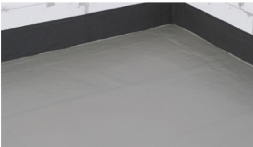
7. Die Trockenschichtdicke von PROFI-DICHT-Fläche beträgt ca. 2,1 mm
