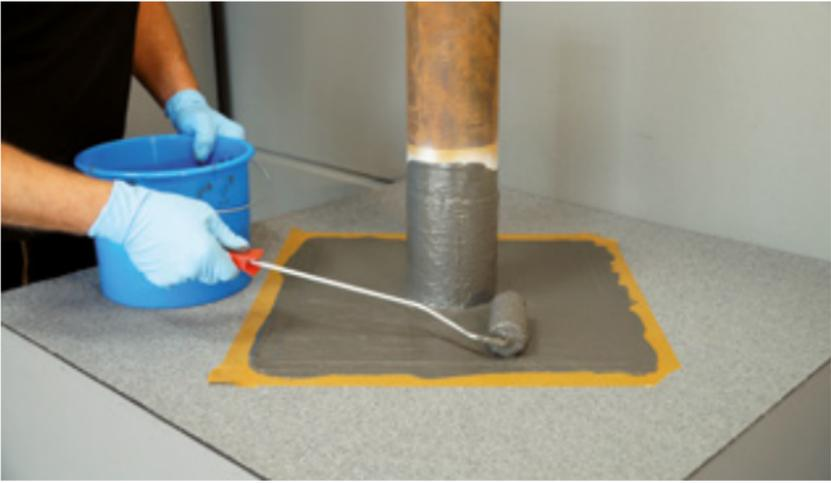
8. Abzudichtenden Bereich satt mit einer Deckschicht von mind.  $1,0 \text{ kg/m}^2$  abdecken
