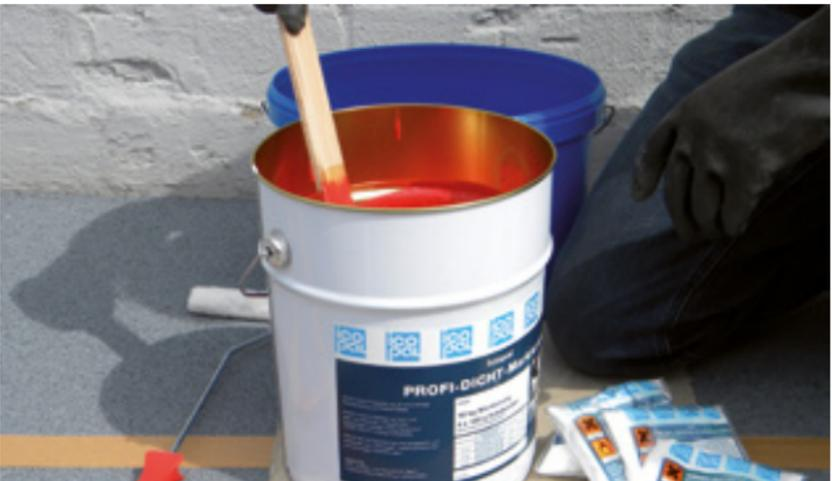
2. PROFU-DICHT-Markierung gut aufrühren und die benötigte Menge in ein sauberes Gefäß füllen. Nun wird die auf diese Menge und auf die Temperatur abgestimmte Menge an Katalysator zugegeben und gut untergerührt. Mischzeit mind. 2 Minuten
