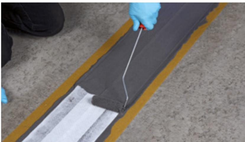
8. Fläche mit einer weiteren Deckschicht, mind.  $1,0 \text{ kg/m}^2$  abdecken
