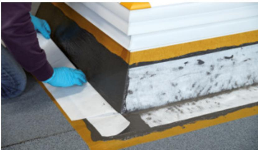
3. Zugeschnittenes PROFIL-DICHT-Vlies einlegen, den Eckbereich so einschneiden, dass es sich blasenfrei anschmiegt
