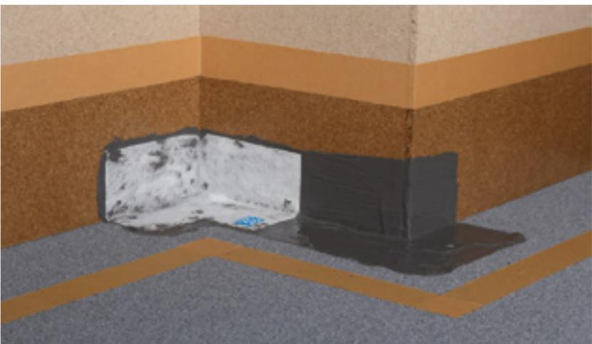
3. Die verarbeitungsfertige PROFI-DICHT-Mischung, mind.  $2,0 \text{ kg/m}^2$ , mit einer Fellrolle satt auftragen und gleichmäßig verteilen
