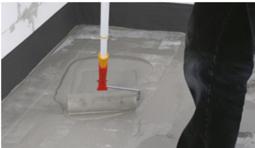
6. Eine Deckschicht aus PROFI-DICHT-Fläche auf dem Vlies gut deckend verteilen
