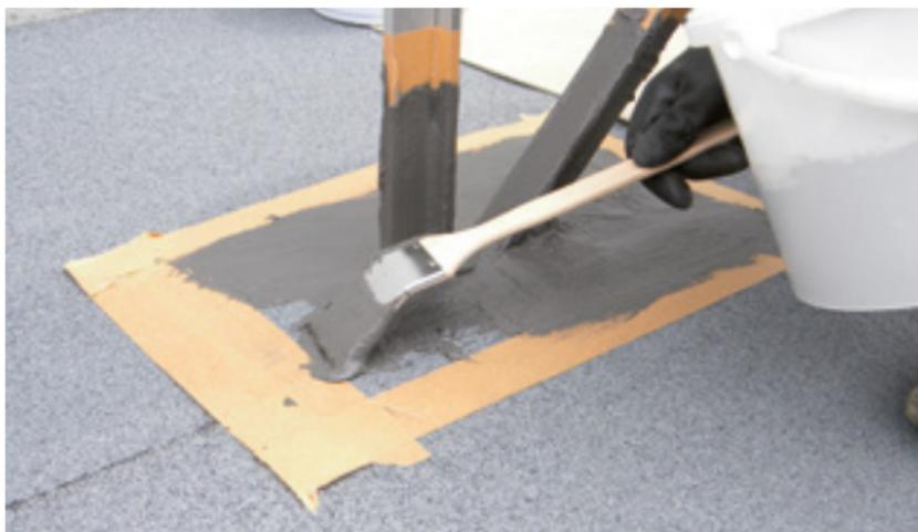
2. PROFI-DICHT-Faserfix wird mit dem Pinsel aufgetragen und geglättet. Der Anschluss der Detailabdichtung sollte ca.  $\geq 10$  cm in die Fläche geführt werden. Die Anschlusshöhen sollen nach Regelwerk hergestellt werden. Abweichungen hiervon sind Sonderlösungen und mit dem Bauherren abzustimmen
