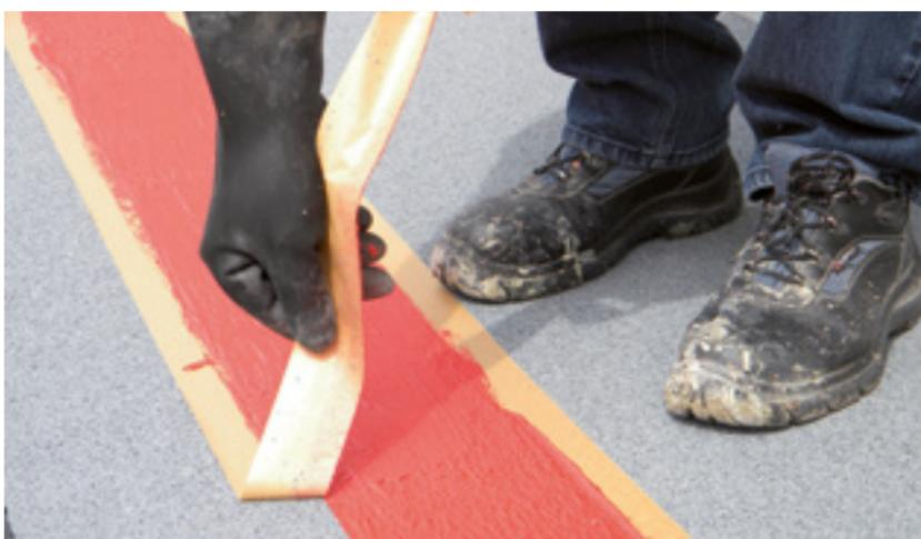
4. Das Klebeband muss entfernt werden bevor PROFI-DICHT-Markierung ausgehärtet ist. Danach ist die Markierung je nach Bauteil-/ Umgebungstemperatur nach ca. 30 - 45 Minuten regenfest
