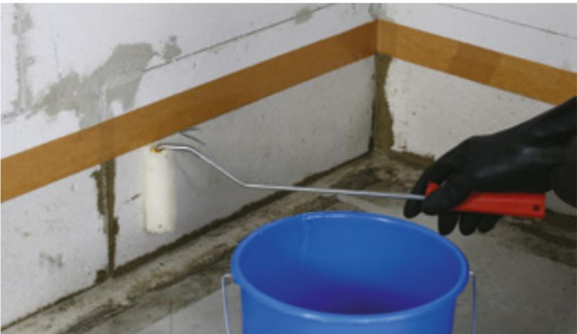
1. Die für die Abdichtung vorgesehene Fläche ggf. mit PROFI-DICHT-Grundierung grundieren
