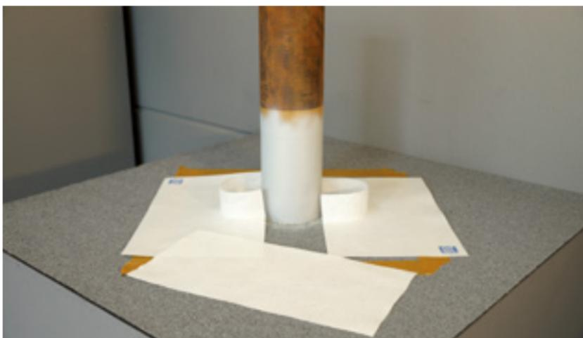
4. PROFI-DICHT-Vliesformteil Rohrmanschette bereitlegen und einen 15er Vlieszuschnitt in entsprechender Länge für die Rohrwandung anfertigen
