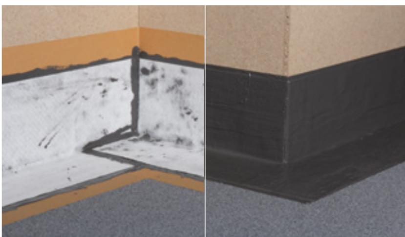
7. Abzudichtenden Bereich satt mit einer Deckschicht von mind.  $1,0 \text{ kg/m}^2$  abdecken
