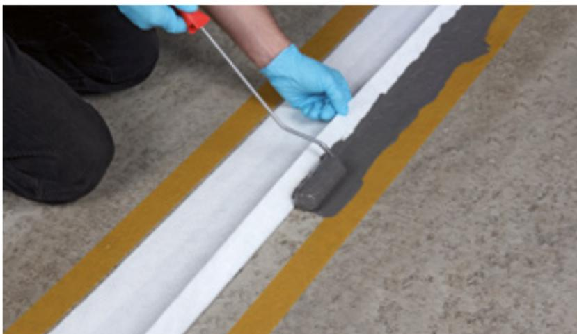
5. Nicht klebende Vlies-Streifen anheben und die verarbeitungsfertige PROFI-DICHT-Mischung mit einer Fellrolle satt auf den Untergrund auftragen, min.  $2,0 \text{ kg/m}^2$
