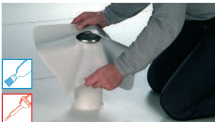
Flansch über das Rohr stülpen, wobei ein 2 cm hoher Kragen entsteht. Flansch auf die Fläche aufschweißen.
