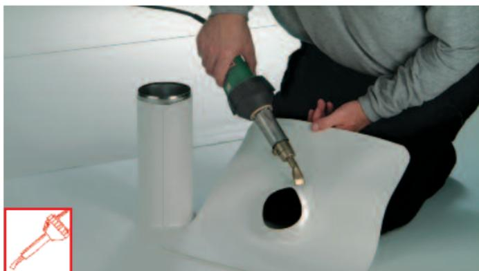
Flansch aus TECTOFIN **R** herstellen. Runder Ausschnitt ca. 2/3 Rohrdurchmesser. Beidseitig erwärmen, bis Ober- und Unterseite speckig glänzen.
