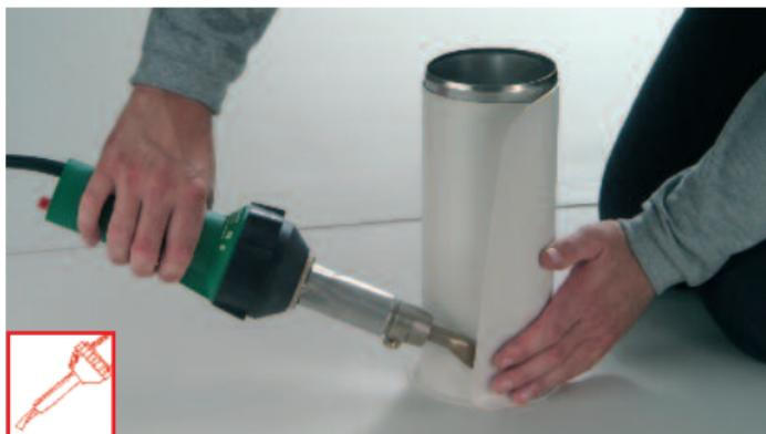
TECTOFIN **R**-Manschette straff umlegen und mit Heißluft punktwise heften. Naht heiß verschweißen und Manschette nach unten stauchen, so dass sie sich ca. 2 cm breit horizontal weitet.
