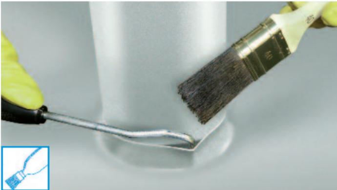
Flansch gut abkühlen lassen, Flansch und TECTOFIN **R**-Manschette mit Quellschweißmittel verschweißen, wobei der „Kragen“ z. B. mit einem Nahtprüfer oder Schraubendreher geöffnet wird, so dass das Quellschweißmittel einlaufen kann.
