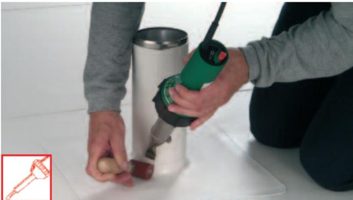
Nach dem Ablüften des Quellschweißmittels (ca. 3–4 Std.) den T-Stoß im Bereich Manschette-Flansch ausschweißen.
