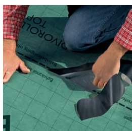
1. Folie abziehen und Bahnen verkleben
