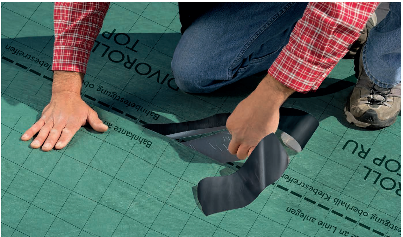
Unterdeck- und Unterspannbahnen der 2S-Varianten mit abgestimmter Kleber-Rezeptur.
