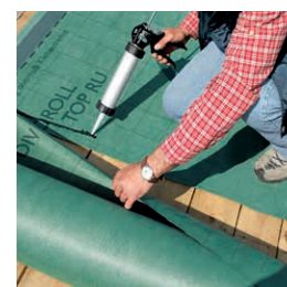
3. Verklebung von Querstößen und aufgehenden Bauteilen
