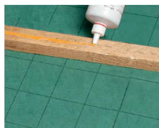
2. Divoroll Dichtmasse auf die Konterlatte auftragen
