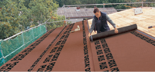
Die Verlegung erfolgt parallel zur Traufe.
