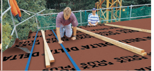
Abdichtung mit DELTA®-Nageldichtmaterialien.
