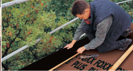
Die Bahn endet am Abschluss der Holzschalung.
