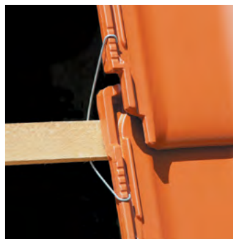
Die Fixierungskerben für die Sturmklammern.
