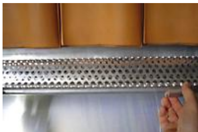
1. Lochblechprofil unter die Dacheindeckung schieben
