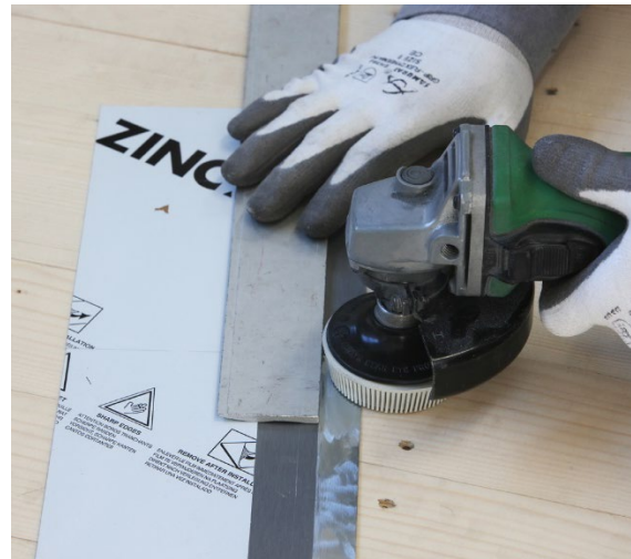
Abrasives Entfernen der Oberfläche
