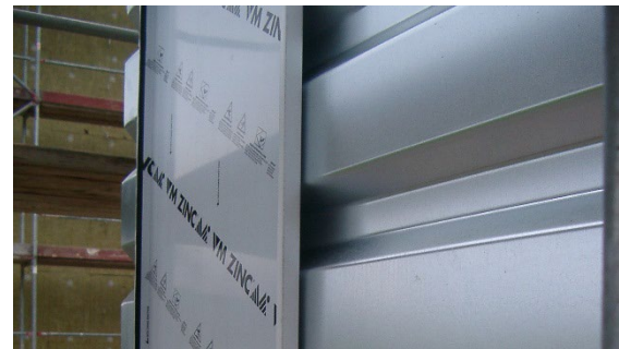
Verlegung auf Stahltrapezprofilen
