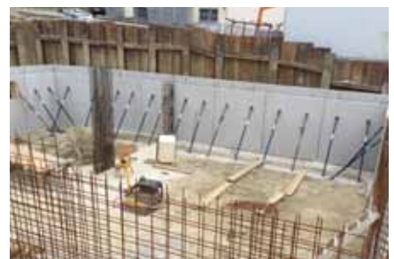
BTS M: Schrägstützen / Baustelleneinrichtung
