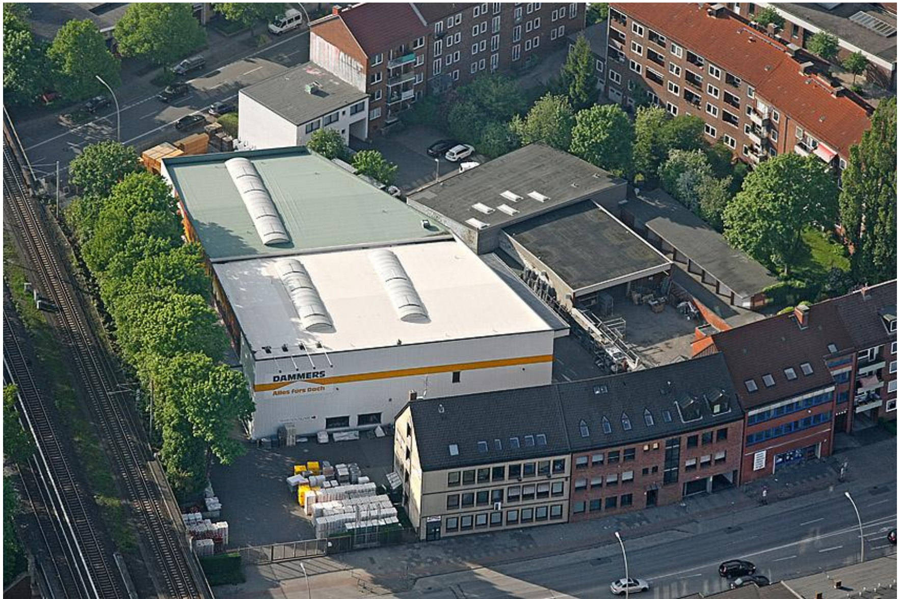
STAMMSITZ - Hamburg BARMBEK Bramfelder Straße 51 * 22305 Hamburg
